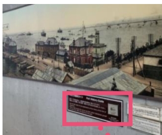
開港広場前に プレートを設置
